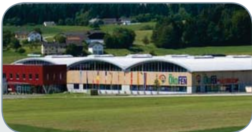
Moederbedrijf in Niederkappel (Oostenrijk)
